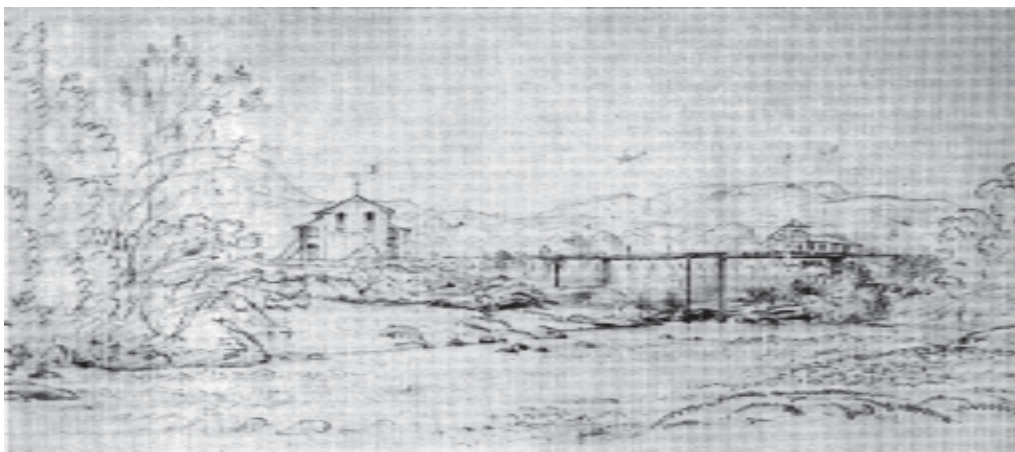
117. A igreja das Mercês e a ponte sobre o rio das Almas, em Pirenópolis, conforme o desenho de W. J. Burchell, em 1827. Sobre a ponte o hoje inexistente palácio mourisco dos Frota.
