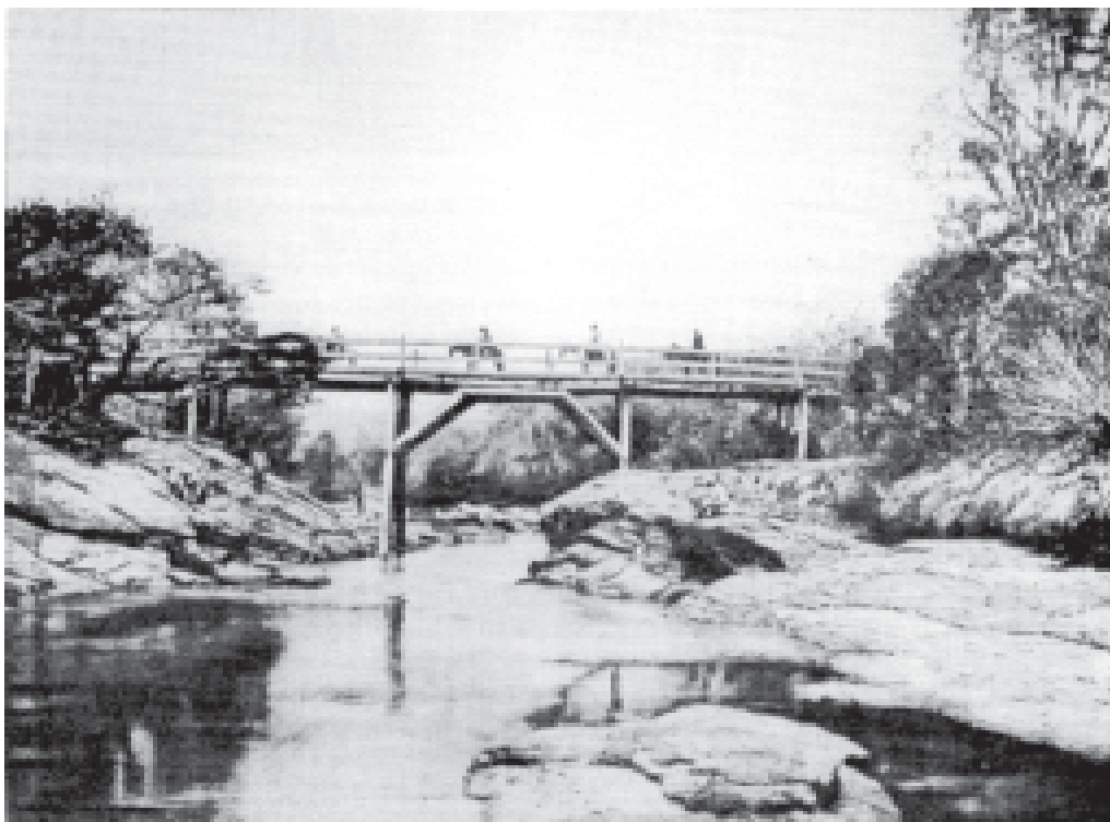
83. Ponte sobre o rio Areias, na Estrada Real para Pirenópolis, fins do Século XIX. Foto da Comissão Cruls, 1892.
