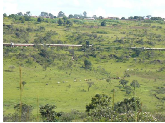
Foto 2 – Tubulações aéreas da CAESB, sítio Taguatinga
