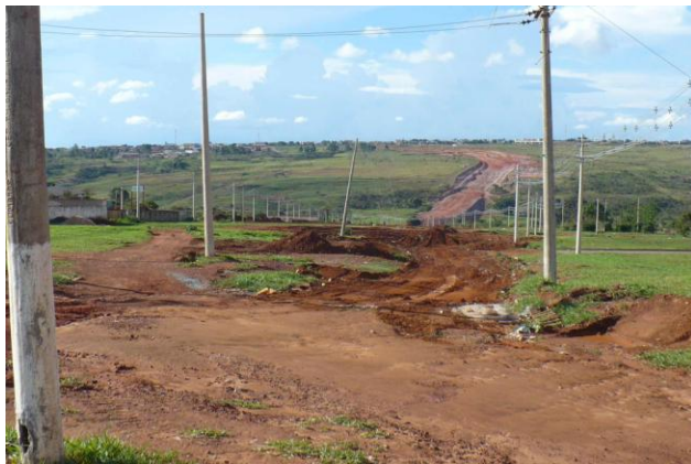
Foto 3 – Via DF-459 em construção, ano 2008
